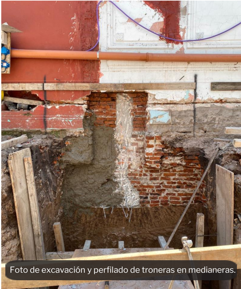
Foto de excavación y perfilado de troneras en medianeras.
